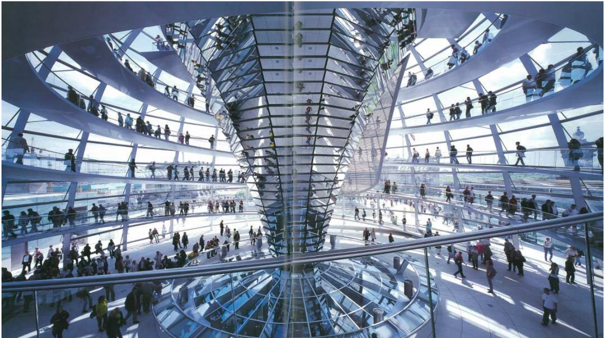
Figura 44 – Cúpula acessível ao público e Cone de lamelas reflectoras que difundem a luz para a câmara parlamentar.
