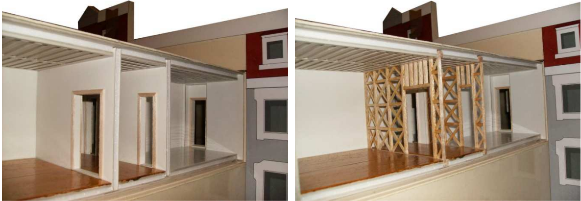
Figura 67 – Perspectivas da maqueta com parede interior opaca (direita) e com estrutura à vista (esquerda)
